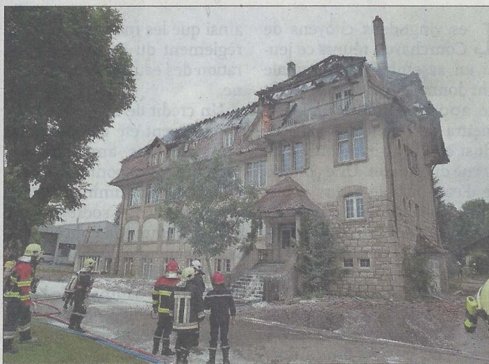
Intervention des pompiers dans l'ancien immeuble Longines.
