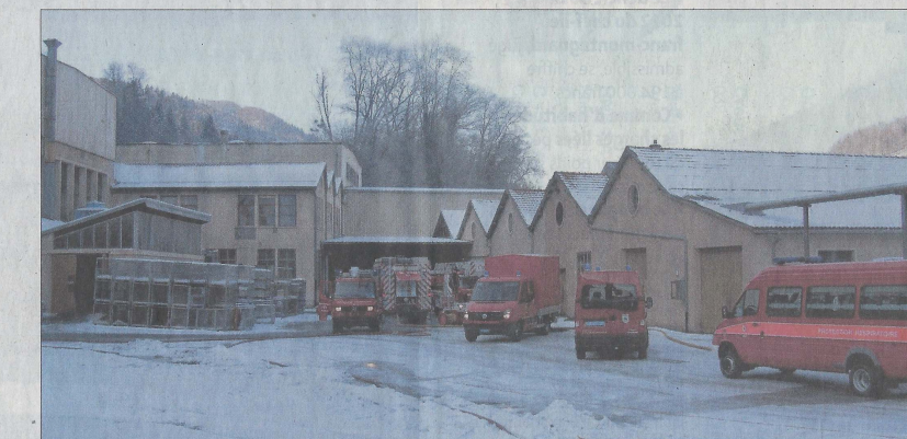
Plus de peur que de mal hier matin à l'usine Benteler de Saint-Ursanne où un incendie s'est déclaré dans un bâtiment.
