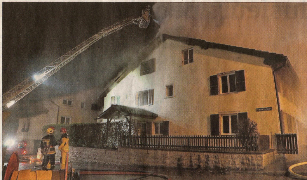
Après avoir maîtrisé les flammes qui ont ravagé une maison de Develier, les pompiers ont surveillé le bâtiment pour éviter les reprises.
