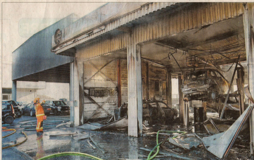
Le Garage du Passage, à Courtételle, a été la proie d'un important incendie hier. Plusieurs véhicules ont été entièrement carbonisés.
